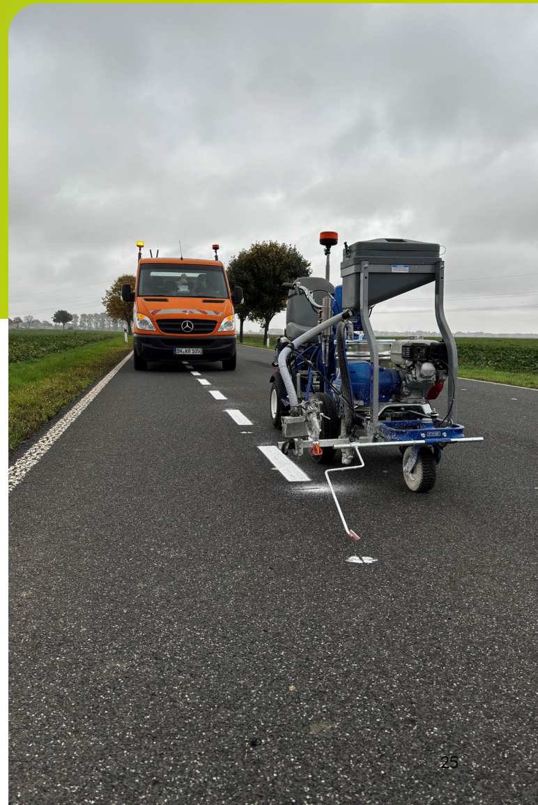
K16 Schutzstreifen außerorts bei Markierungsarbeiten (Foto: Kreis Düren)
